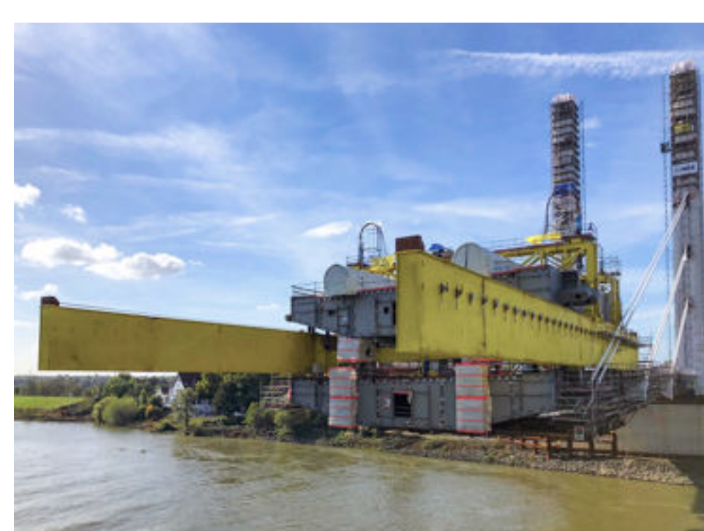
Kleinere Brückensegmente werden am vorderen Ende der Brücke angeschweißt.
