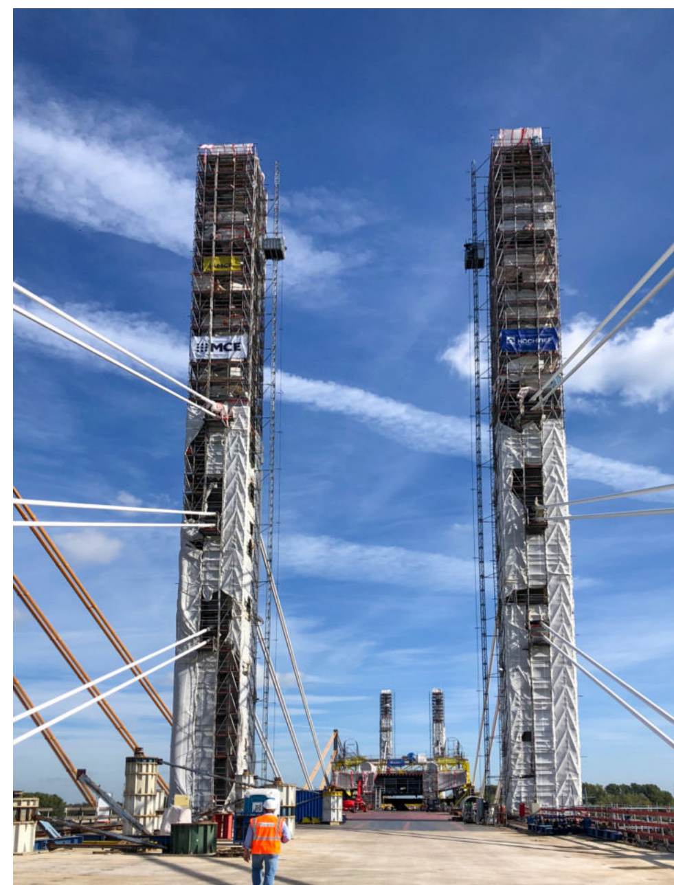
Stahlseile verbinden die Pylonen mit der Brücke.
